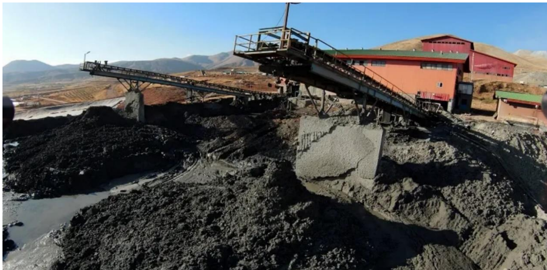
شکل ۳-۱۷. تخلیه پالپ فرآوری فیلتر شده و تخلیه آن در دیوی موقت باطله جهت انتقال به سد باطله
