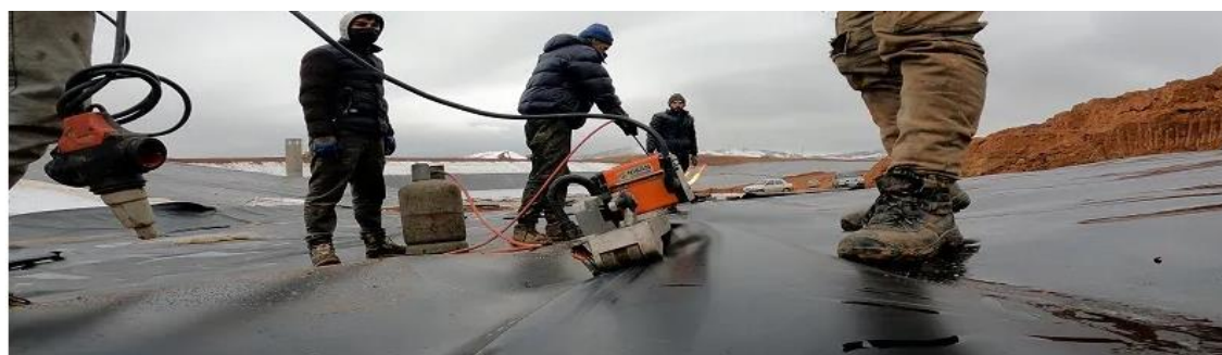
شکل ۳-۲۲. اجرای اورلپ لایه ژئوممبران بر روی سه لایه رس کمپاکت شده
