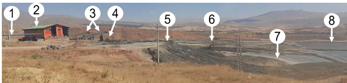
شکل ۳-۲۱. دورنمایی از واحد فیلتراسیون و سد باطله فرآوری طلای زرشوران با نمایش ترتیب عملیات اصلی (دید جنوب شرقی) ۱. خط ورود باطله (پالپ بدون کربن باردار) از آخرین تانک لچینک، ۲. ساختمان فیلتراسیون، ۳. نوارهای تخلیه پالپ باطله ۴. باطله با رطوبت تا ۳۰٪، ۵. دیوی موقت باطله در بالادست سد، ۶. پخش باطله در سد توسط بیل مکانیکی، ۷. عایق ژئوممبرین بدون لایه‌های بالایی، ۸. تاج سد
