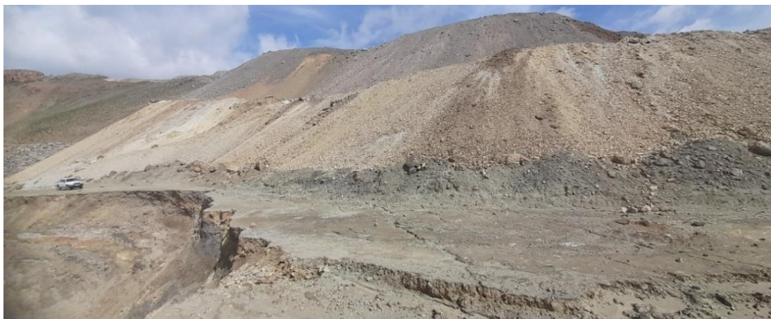
شکل ۴-۲. نمونه‌ای از لغزش زمین ناشی از حجم بالای باطله (دامپ PR) و ریزش آن به مسیر رودخانه
